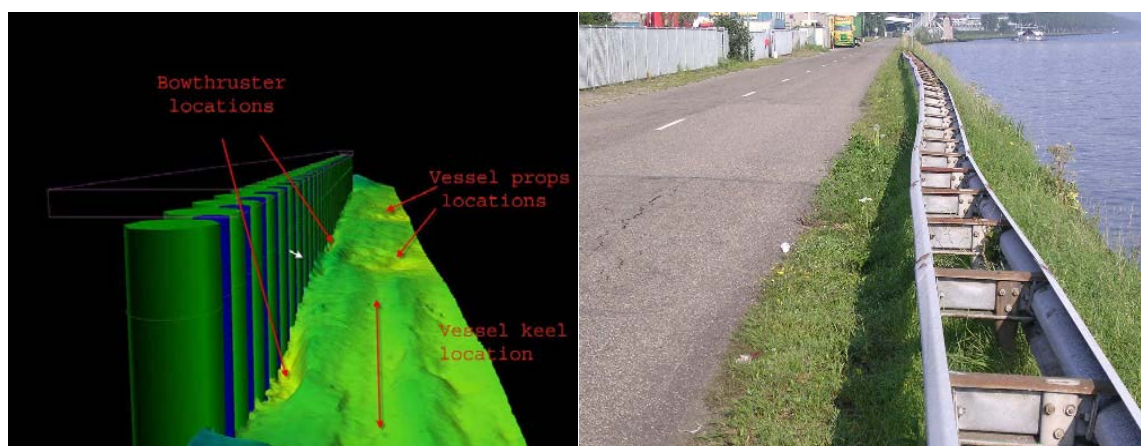
Lokale ontgrondingen nabij kademuur ontgrondingen
