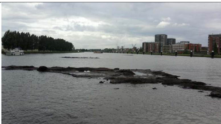
Veenopbarstingen in Gouwekanaal, ter hoogte van Julianasluis
