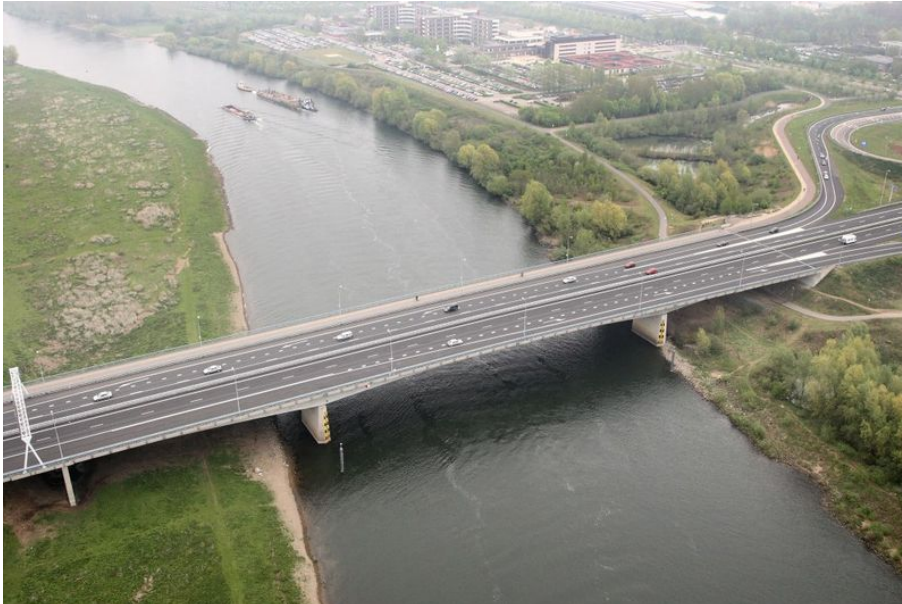
Foto 1: Zuiderbrug (bron: http://www.wegenwiki.nl/Zuiderbrug )
