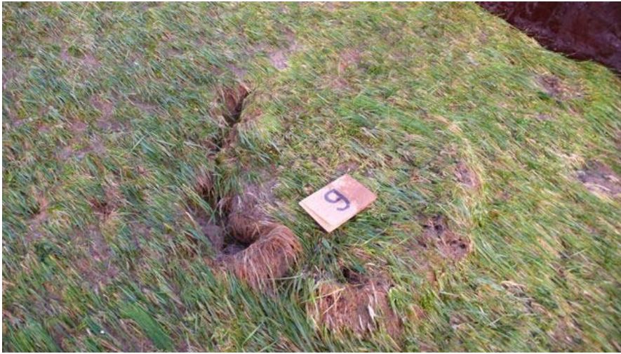
Figuur B25. Kattendijke; sectie 2, na 2 uur van 50 l/s per m. De paal op het talud werd eruit geslagen. Deze paal stond verticaal (dus niet loodrecht op het talud), 30 cm diep, en door de overslaande golf werd een moot klei met gras omhoog gedrukt en iets naar beneden.
