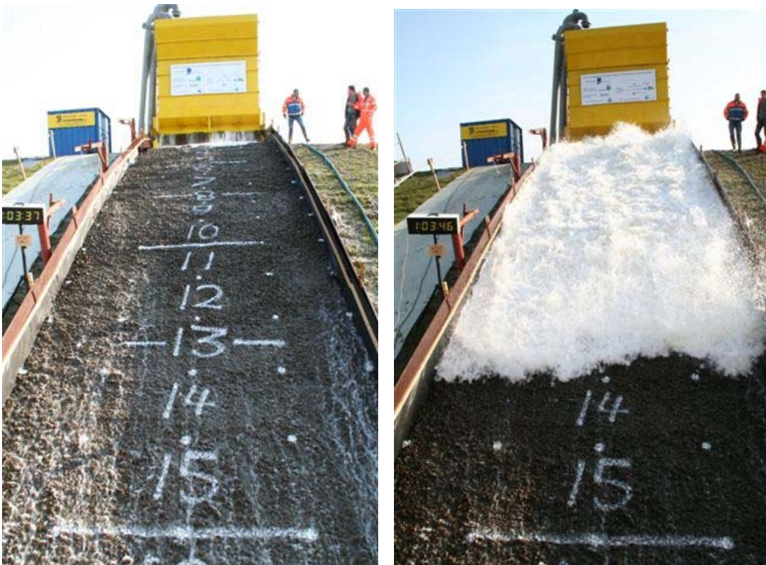
Figuur B30. Kattendijke, laatste proef op elastocoast. Met twee extra pompen werd een overslagdebiet gehaald van 125 l/s per m. Hierbij moet worden bedacht dat overslagvolumes groter dan 5,5 m 3 per m niet konden worden gesimuleerd (maximum inhoud van de simulator). Bij 125 l/s per m komen gedurende 2 uur 10 overslagen voor die groter zijn, 4 daarvan groter dan 7 m 3 per m. Zowel de elastocoast als de open asfaltbeton gaven geen schade te zien.
