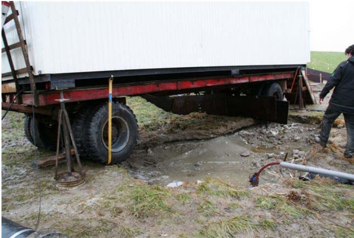
Figuur B19. Kattendijke sectie 1. Schade aan de achterkant van de onderhoudsweg die begon bij 30 l/s per m (het talud ligt op de foto aan de andere kant van de meetwater). De meetwagen moest na 1 uur 75 l/s per worden weggehaald om niet in het gat te vallen (de foto is genomen net voordat de meetwagen is weggehaald).
