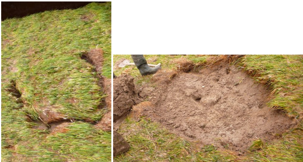
Figuur 4.7 Uiteindelijk resultaat; Kattendijke, proefvak 2 na 50 l/s per m. Gedurende de proeven erodeerde de klei onder de plag, maar deze bleef zelf wel liggen. Na de proef is de plag afgegraven (rechts) en bleken daaronder diverse mollengaten te zitten.
