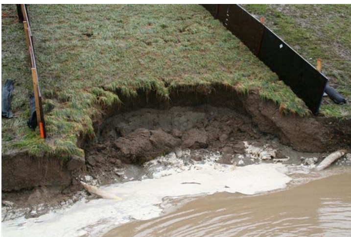
Figuur B21. Eindresultaat Kattendijke, sectie 1. Proef 75 l/s per m gestopt na 5 uur en 40 minuten. Het gat in de onderhoudsweg had het talud bereikt en kroop omhoog langs het talud (head cut erosie). De zandkern was ook hier duidelijk bereikt en de schadeontwikkeling ging vlak voor het stoppen van de proef erg snel. Het talud zelf heeft echter geen wezenlijk schade ondervonden.
