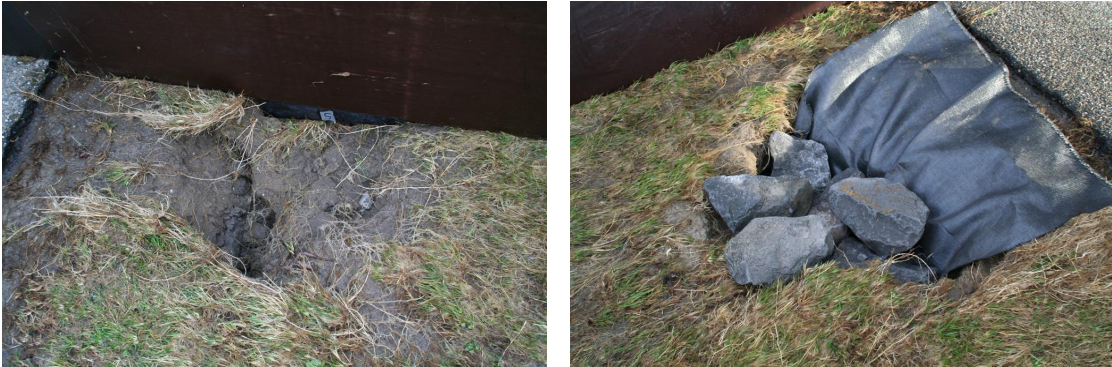
Figuur 7-5 Het dichten van de gaten met breuksteen nabij de asfaltweg
