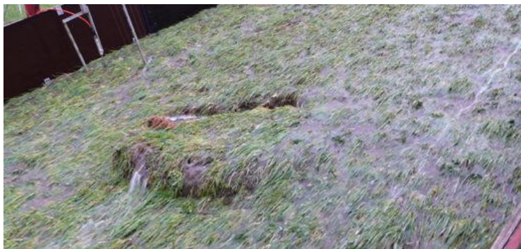
Figuur 4.6 Kattendijke; proefvak 2 na voortzetten met 50 l/s per m. Verwachting was dat de grasplag er afgespoeld zou worden bij een grote golf.
