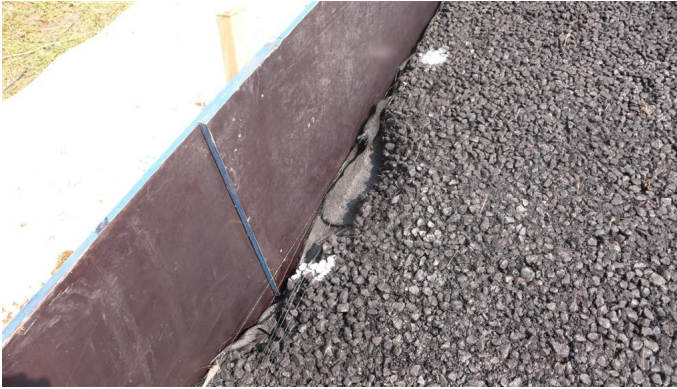
Figuur 10-2 Randeffect open steenasfalt
