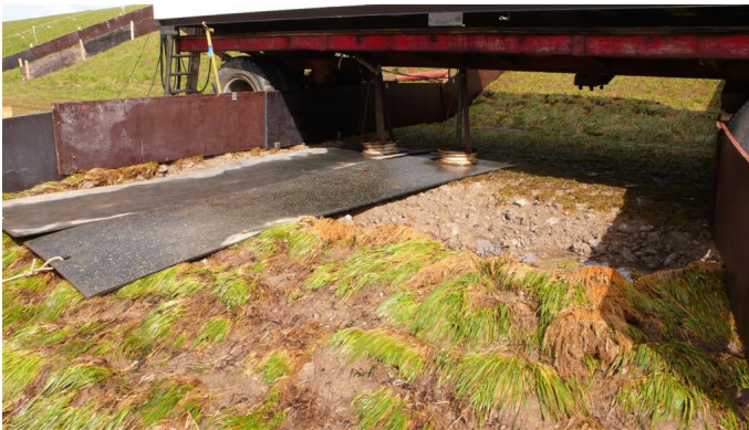
Figuur 8-1 Schade achter de onderhoudsweg
