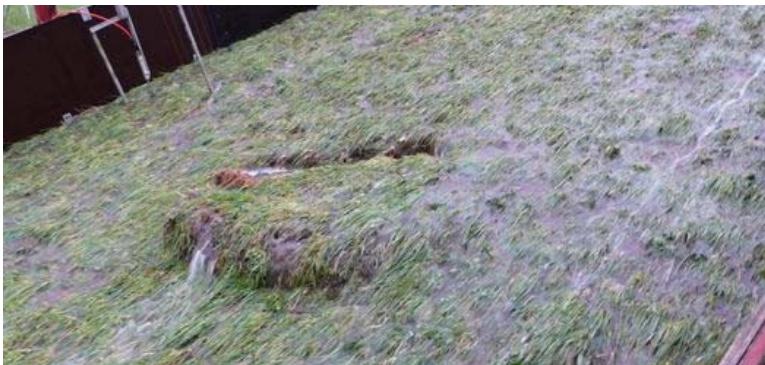
Figuur B26. Kattendijke; sectie 2, bij doorzetten proef 50 l/s per m na initiële schade door uitgeslagen paal. De verwachting was dat de plag eruit zou slaan.
