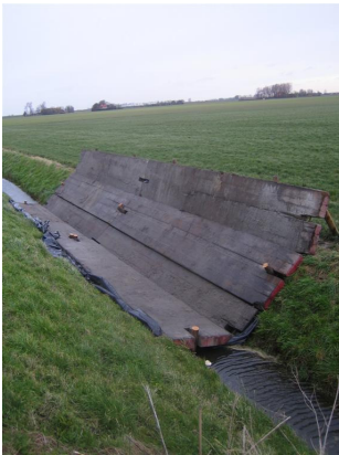
Figuur 2-9 Draglineschotten ter bescherming van het talud (St. Philipsland)
