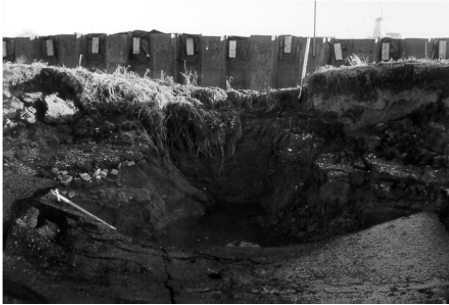
Overzicht ontgrondingskuil (9 december)
