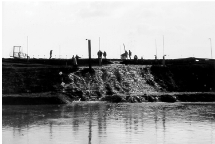
Overlopen van het binnentalud rond 13:45.
