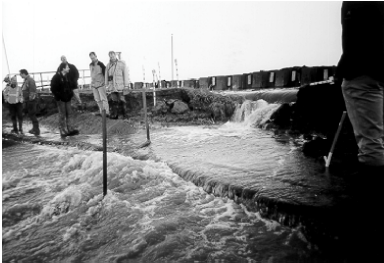
Figuur 2.2: Bres in tuimelkade, met stroming grotendeels onder de asfaltstrook door.
