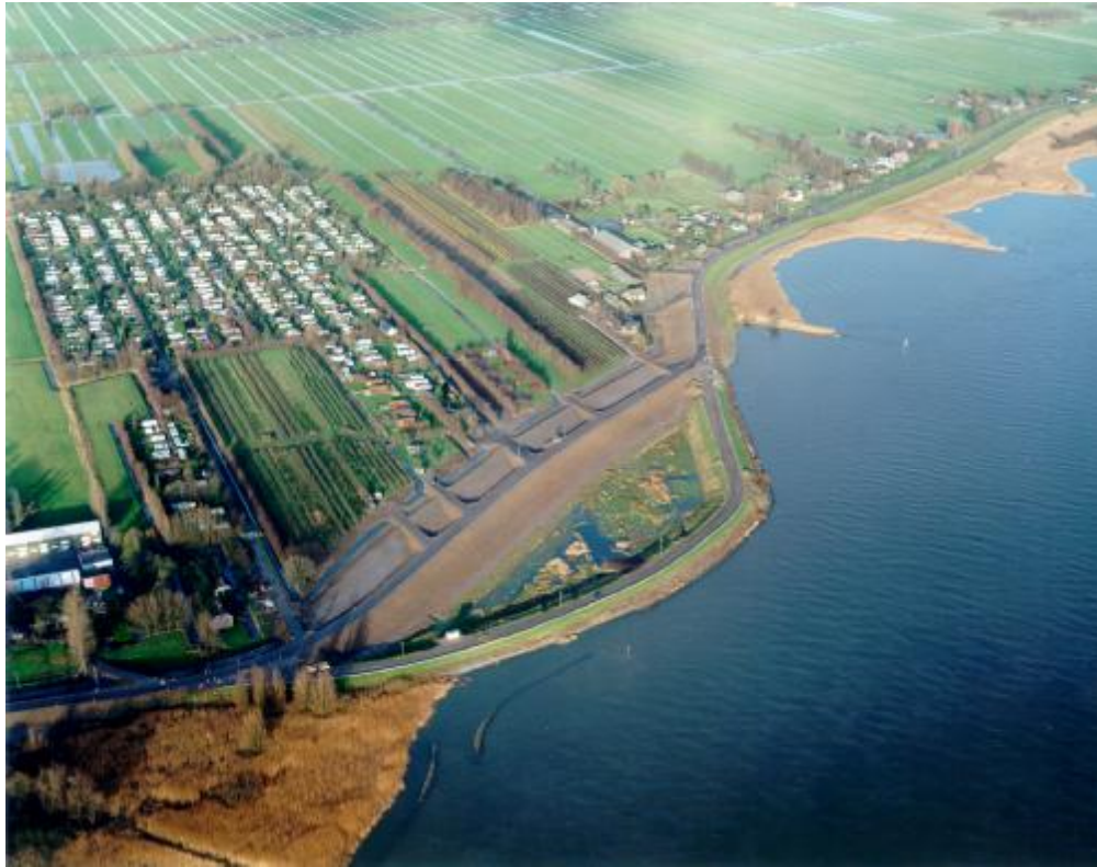
Figuur 2.1: luchtfoto Proefvak Bergambacht met oude en nieuwe Lekdijk
