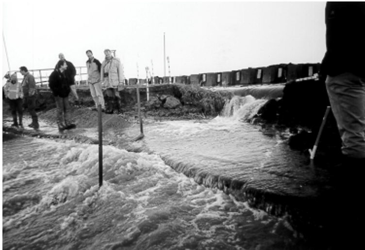
Figuur 7.2: Bres in tuimelkade, met stroming grotendeels onder de asfaltstrook door.
