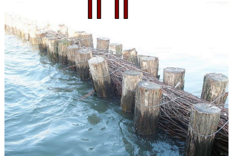
Figuur 2.4 Voorbeeld van een wilgenscherm in een kribvak nabij Ewijk
