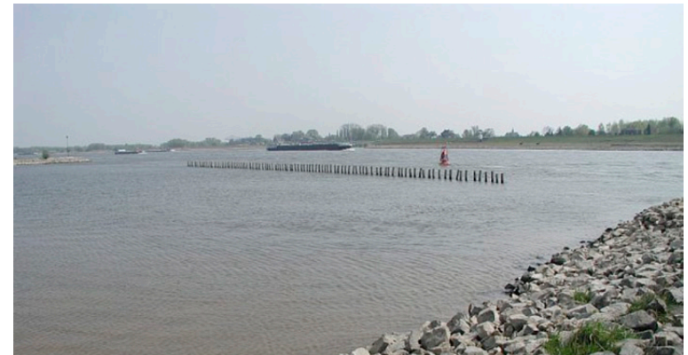
Figuur 2.3 Voorbeeld van een palenrij die een kribvak nabij Ewijk gedeeltelijk afsluit
