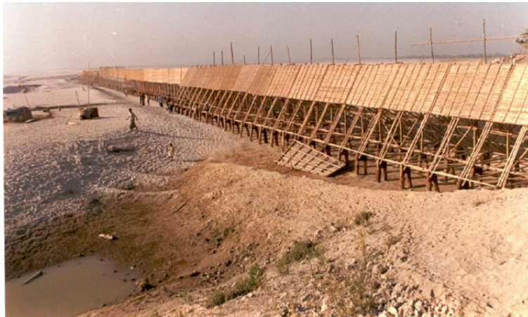
Tijdelijke (erodeerbare) dammen (bedekt met bakstenen) om lokaal sedimentatie te bevorderen, die elders door erosie wordt gecompenseerd. (Brahmaputra-Jamuna, Bangladesh)
