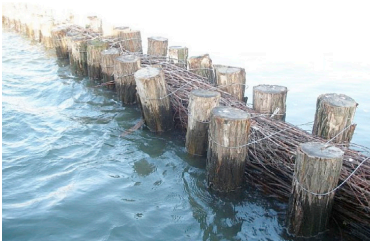
Figuur 3.5 Enkelvoudig wilgenscherm tussen houten palen
