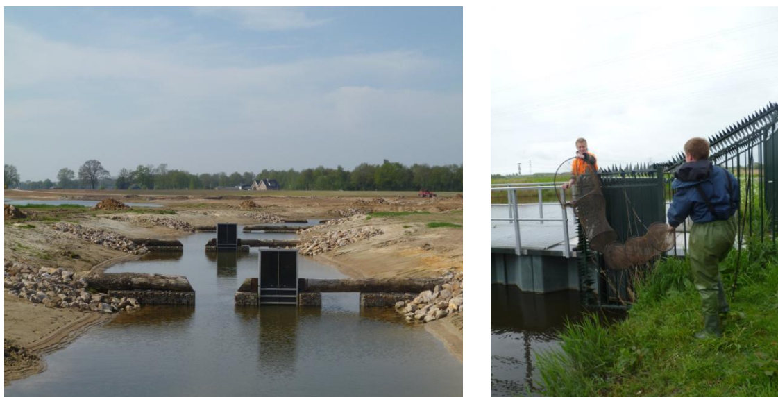
Figuur 1 Nieuw geconstrueerde vispassage in het beheergebied van Waterschap Velt en Vecht (links) en controle van een fuik tijdens de ecologische monitoring van een vispassage door Arcadis (rechts). (Foto's: I. Willemse)
