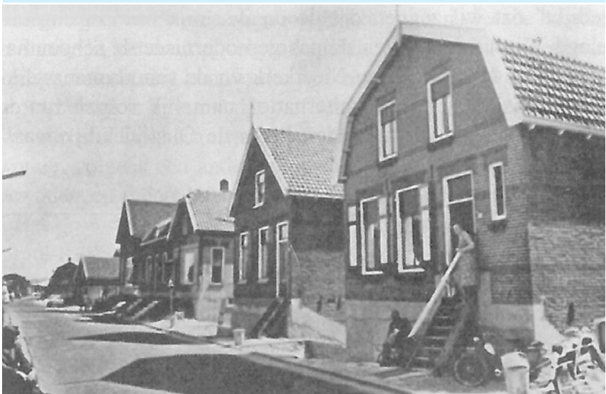
Gevijzelde huizen te Middelland, net voor de dijk werd opgehoogd.
