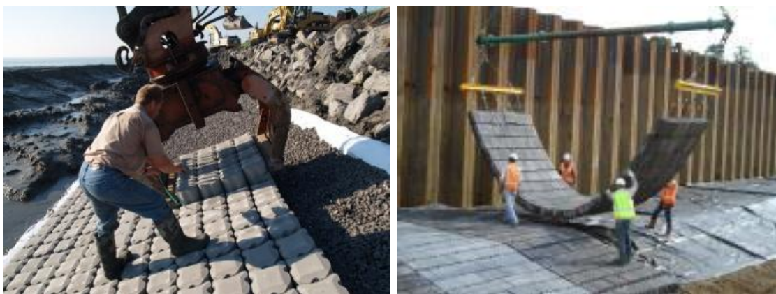
Figuur I-3: Plaatsing gezette bekleding (links) en plaatsing blokkenmat (rechts)
