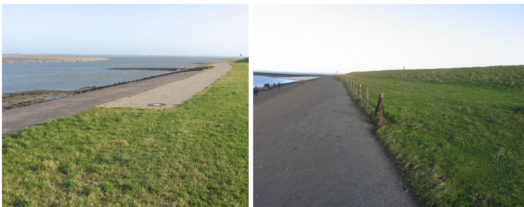
Figuur I-5: Monolieten bekleding asfalt
