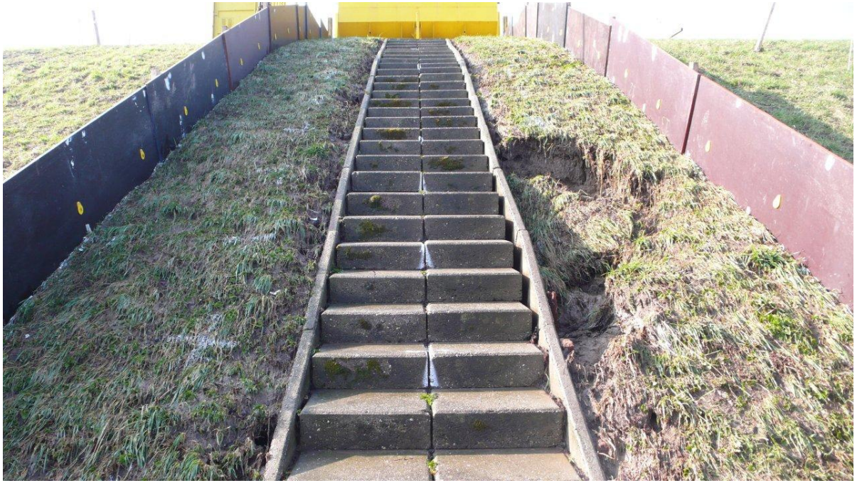
Figuur B82. Tholen. Sectie 2, trap. Bezweken talud.
