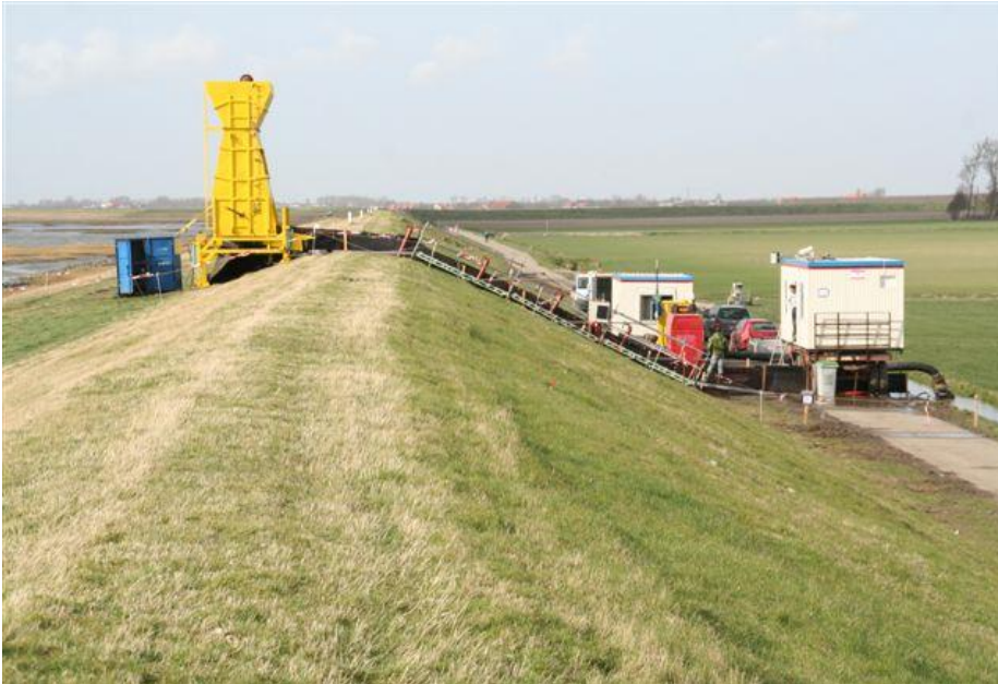
Figuur 4.4 Meetopstelling van de golfoverslagsimulator op een dijk.
