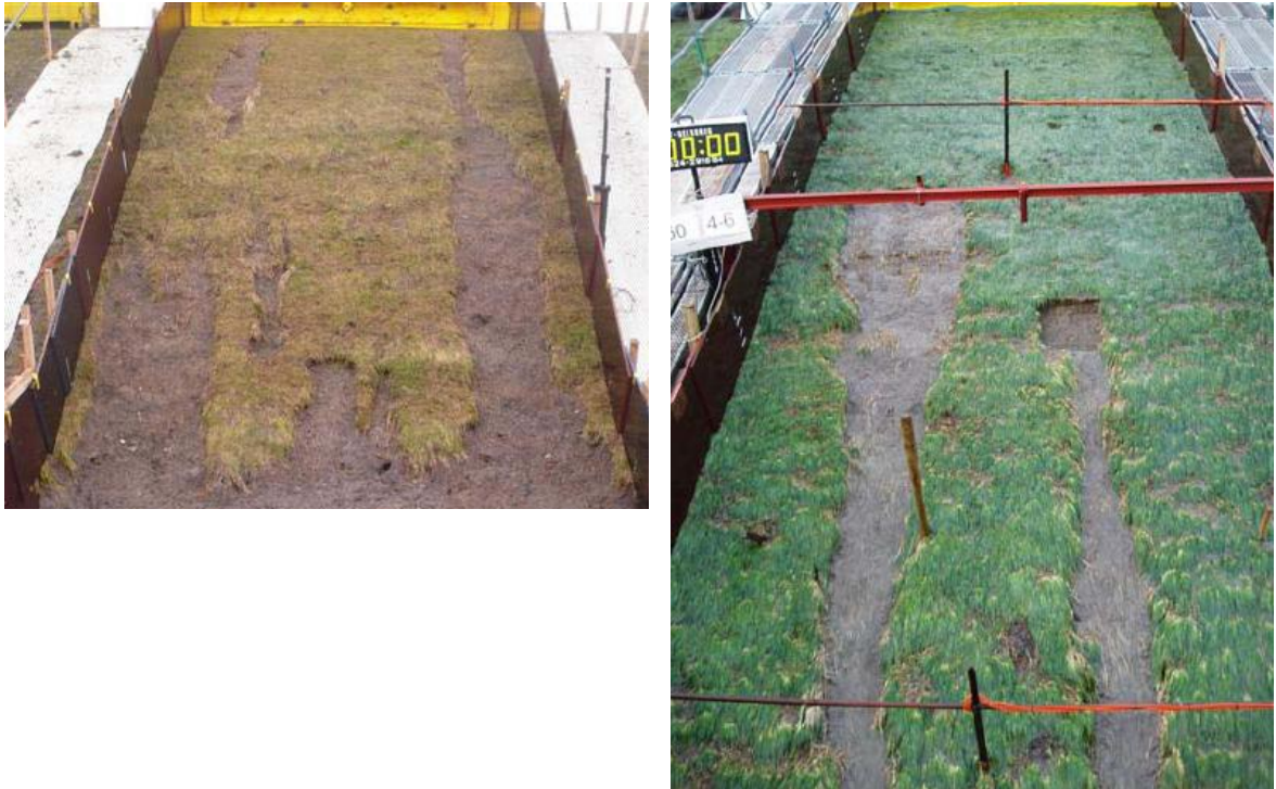
Figuur 5.5 Afstropen van een deel van de toplaag (Aflsuitdijk) en afstropen na aanbrengen van schades (Zeedijk bij Delfzijl)
