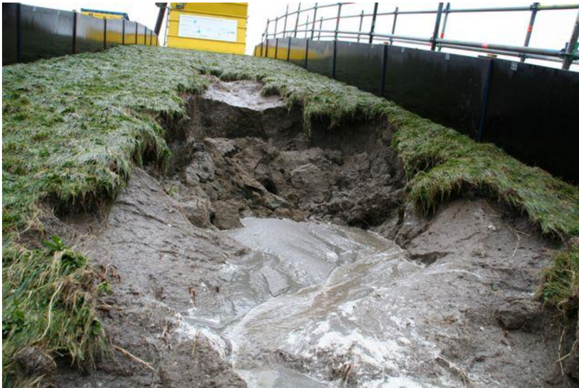
Foto B17. Boonweg. Sectie 4. Na de proef, bezwaken talud en geen schade aan de teen.
