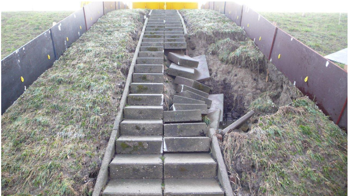
Figuur B83. Tholen. Sectie 2, trap. Bezweken trap.
