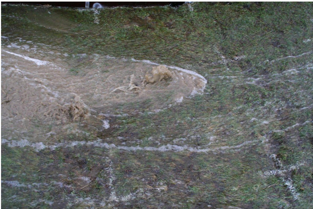
Figuur B89. Tholen. Sectie 3, afrastering. Zandmeevoerende wellen.
