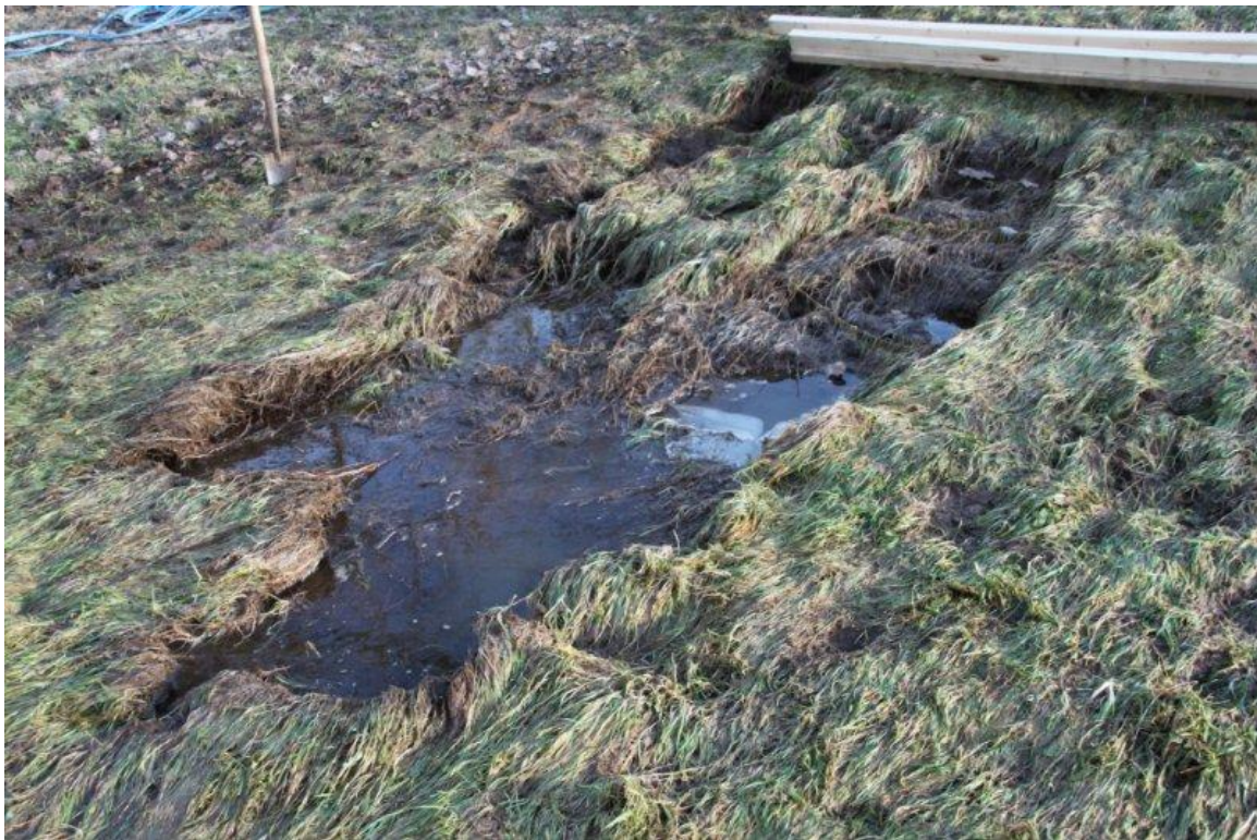
Foto B63. Vechtdijk. Hydraulische metingen; Na de metingen.
