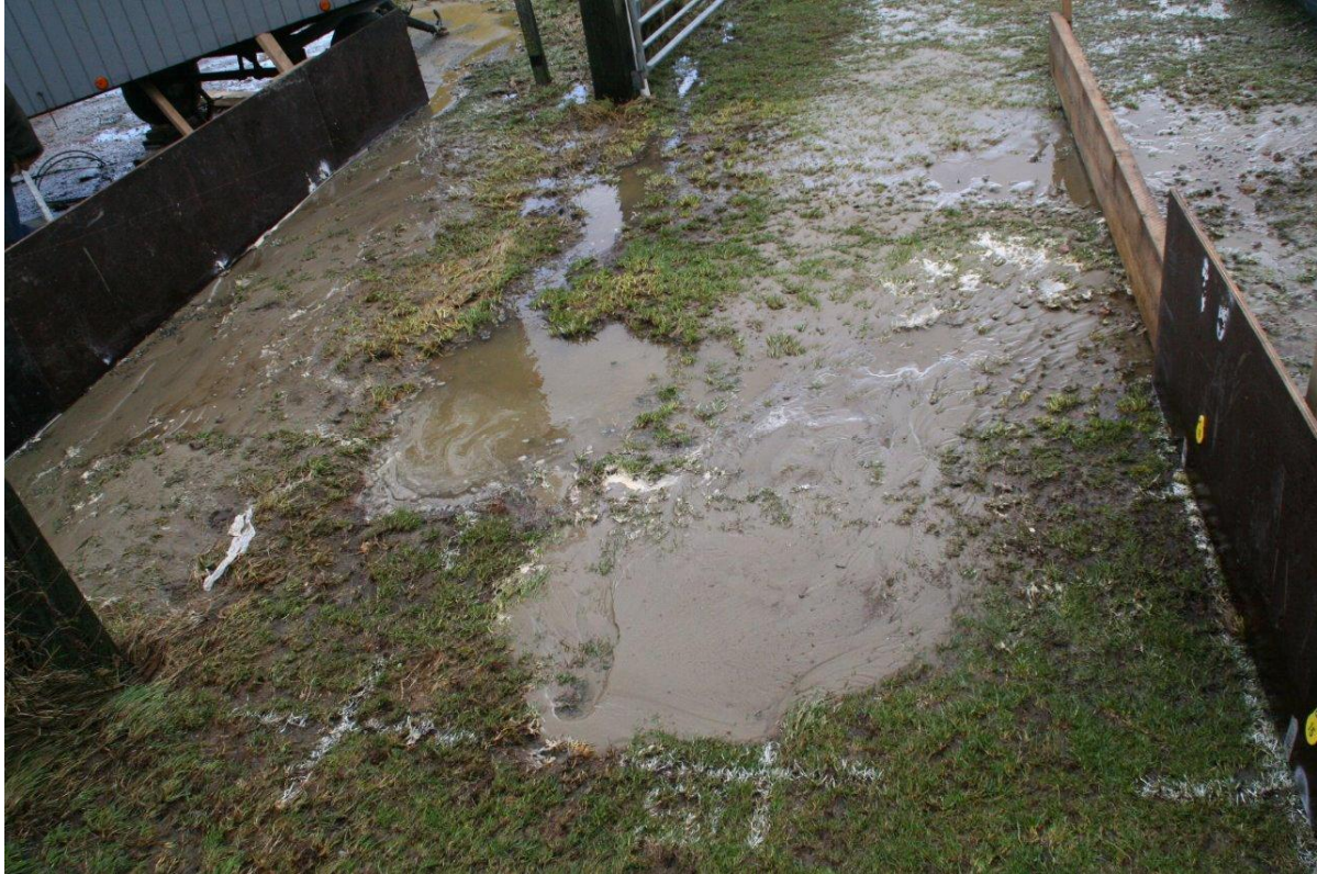
Figuur B86. Tholen. Sectie 3, afrastering. Eerste schade, onderaan talud en op overgang.
