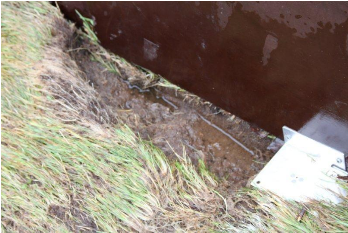
Foto B62. Vechtdijk. Hydraulische metingen; Na de metingen.
