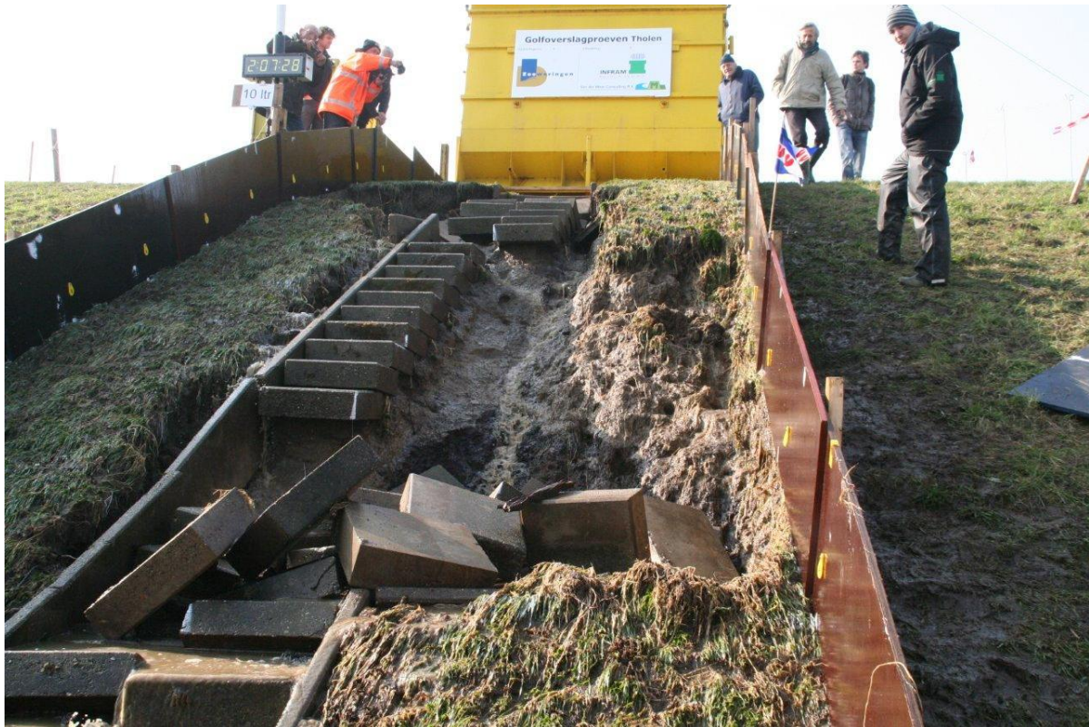
Figuur B84. Tholen. Sectie 2, trap. Volledig bezweken trap en talud.
