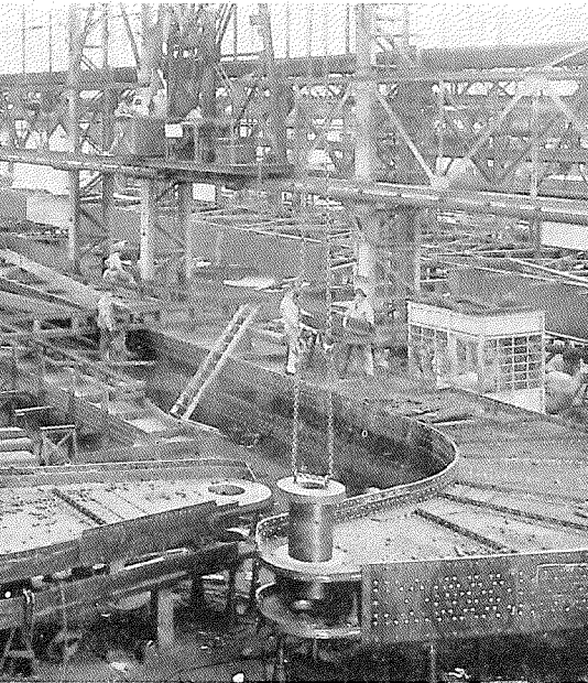
Fig. 2. De in de werkplaats uitgelegde hoofdliggers. Foto „Werkspoor”.
