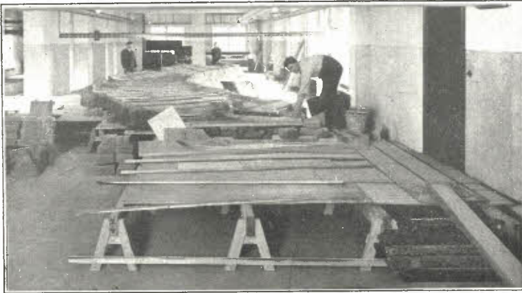
Fig. 3. Het model voor de Vlaardingse havens in aanbouw.
