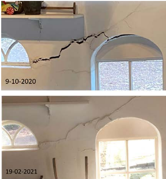
Foto's van scheur opening en sluiting t.g.v. krimp-zwel en metingen ter plaatse (spleetbreedte, neerslag en grondwaterstand. (Foto's: Kees van der Werf)
