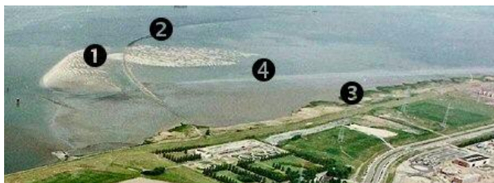
Figuur 2-24: Deze luchtfoto toont de ballastplaat (1), de stroomleidam (2), de smalle strook schor (3) en de uitgebreide slikplaat en vloed-schaar (4) (Scheldeschorren, 2012).
