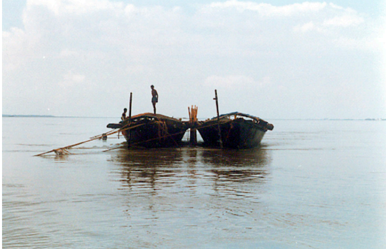
Drijvende oppervlakteschermen om de ruimtelijke verdeling van erosie en sedimentatie te beïnvloeden. (Brahmaputra-Jamuna, Bangladesh)
