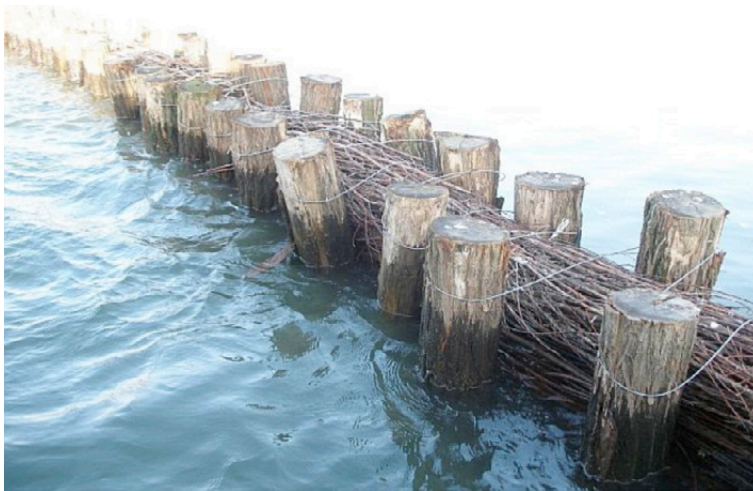
Figuur 3.5 Enkelvoudig wilgenscherm tussen houten palen
