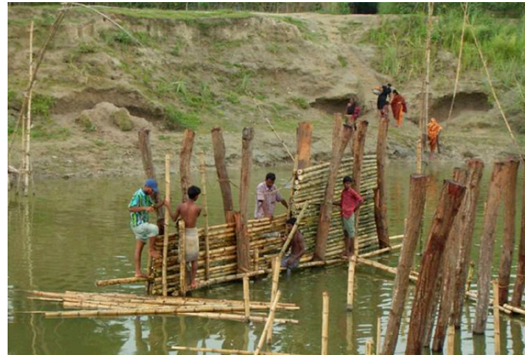
Bodemschermen om de ruimtelijke verdeling van erosie en sedimentatie te beïnvloeden. (Rivier de Elanjani, Bangladesh)
