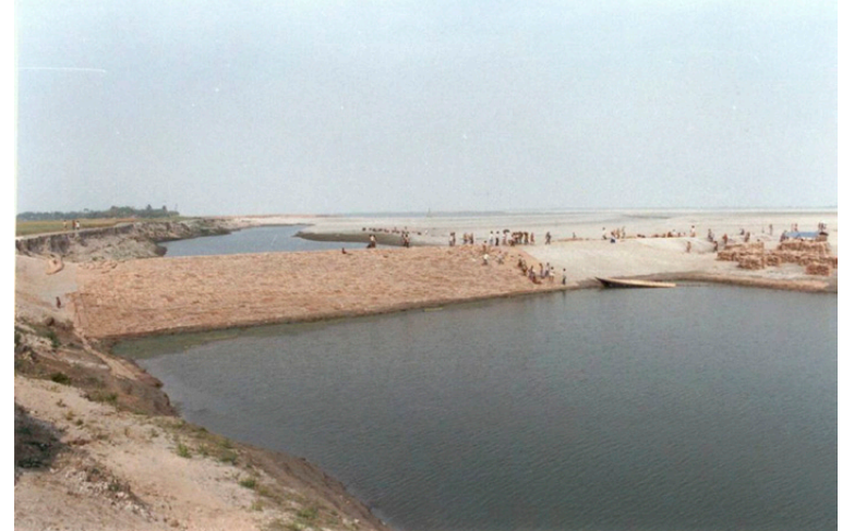
Bandals voor het scheiden van sedimentrijk water, dat leidt tot sedimentatie, en sedimentarm water, dat leidt tot erosie. (Brahmaputra-Jamuna, Bangladesh)
