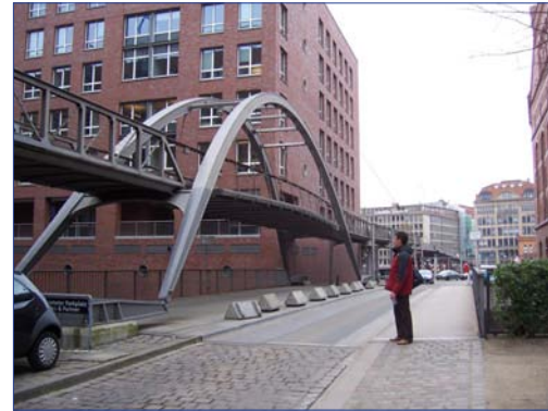
Figuur 6: Hoog aangelegde weg om tijdens hoog water het gebied te verlaten in Hamburg Hafencity
