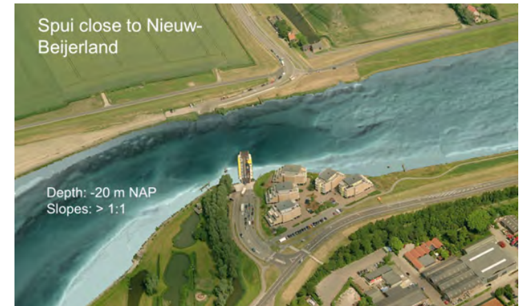
Figuur 2: Ontgrondingskuil bij Nieuw-Beijerland
