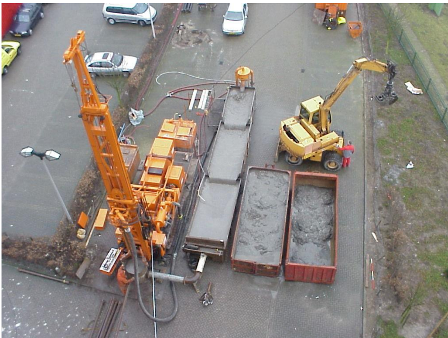
Figuur II-1: Boorstelling zuigboren
