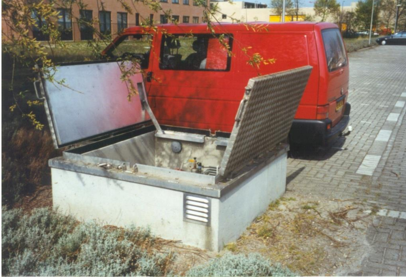
Figuur II-3 Afwerking bron met half-bovengrondse putbehuizing
