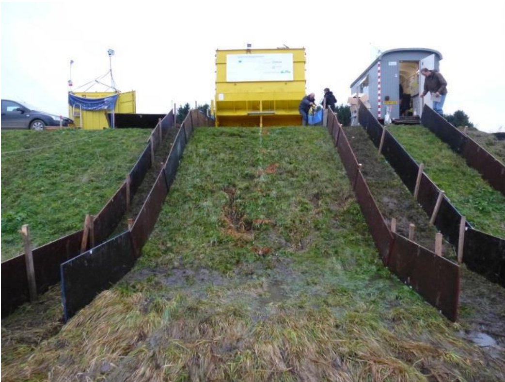
Figuur 72 Nulsituatie grasbekleding Teststrook III, na hydraulische metingen (Infram, 2015, Factual report)
