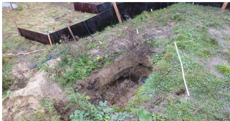
Figuur 10 Het naast de proefstrook ontstane gat na afloop van de proef met 10 l/s/m
