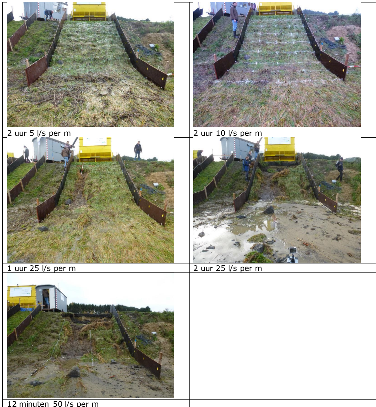
Figuur 12 Overzicht van de schadeontwikkeling tijdens de verschillende uitgevoerde golfverslagproeven
