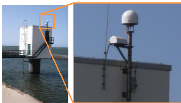
Figuur 7: Getijdenstation IJmuiden waarbij de CAT (platte doosvorm aan de linkerkant) en GNSS-antenne (conusvorm aan de rechterkant) zijn uitvergroot.
