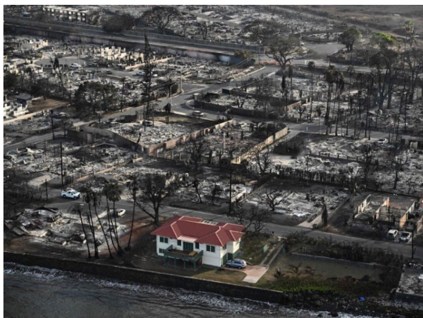
Figuur 5.3 Dit houten huis doorstond de natuurbrandramp in Lahaina, Hawaii, door simpele keuzes in bouwmaterialen en tuinrichting, zoals een metalen dak en stenen als grondbedekking direct tegen het huis aan (bron: NPR, link ).
